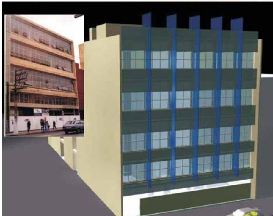
Foto da obra e perspectiva do projeto de transformação do prédio da Avenida Celso Garcia
